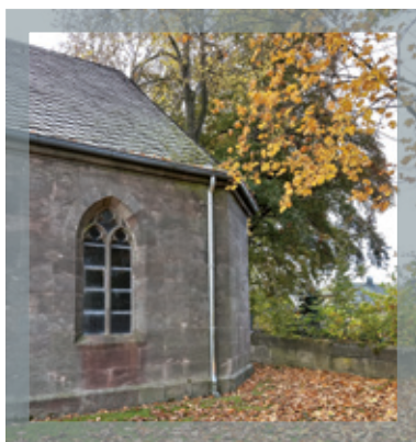
Unsere Leichenhalle erhielt neue Fallrohre.
