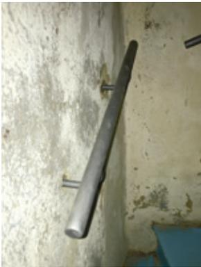
◀ Handläufe, die fehlten, wurden befestigt. So wird die Treppe zur Empore deutlich leichter zu begehen sein.
